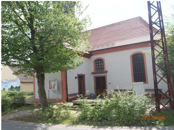
Pilgerherberge mit Kirche in Kleinliebenau
