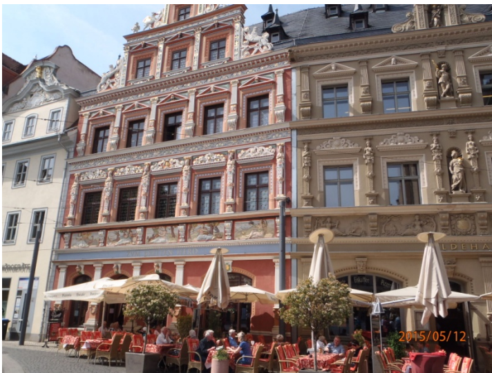
Eines von vielen restaurierten Häusern in Erfurt
